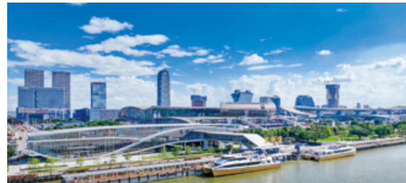
琶洲港澳客运码头
