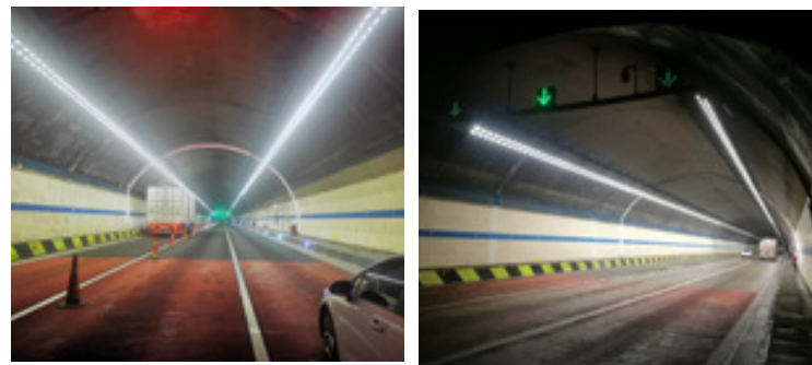
越秀交通对某隧道照明方式进行改造，改造后可节省 17.24% 的能耗
