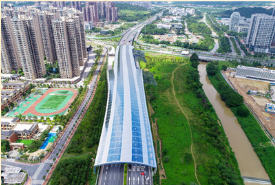
越秀交通北二环高速建设项目
